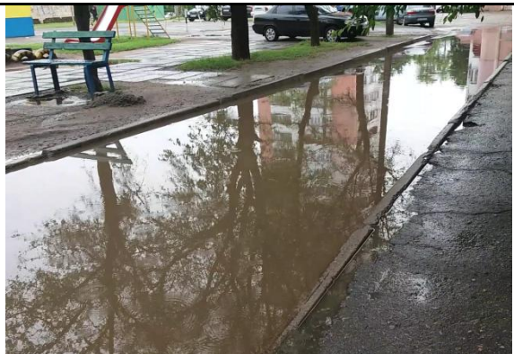
БЫЛО (без водоотвода): Лужа стояла несколько дней после ливня
