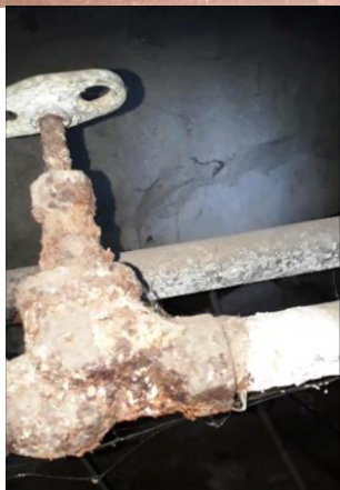
Состояние труб отопления ДО и ПОСЛЕ термомодернизации
